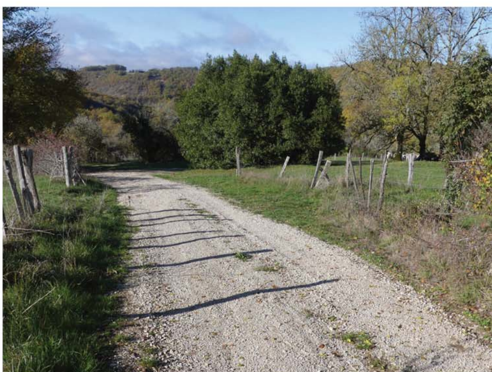
Remise en état du chemin du Mas de Bouyssou au niveau de la maison de Mr et Mme VANEL par étalement de castine chaulée.
