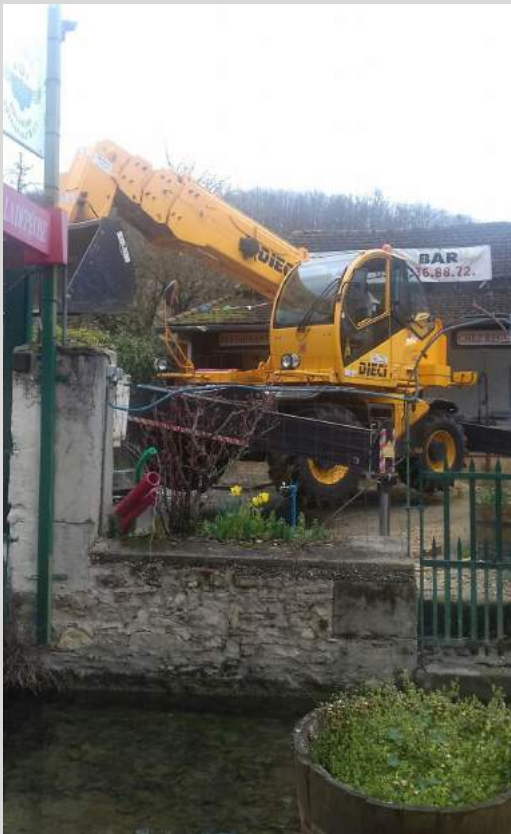
Enfouissement des réseaux ( eau, électricité, téléphone, assainissement)
