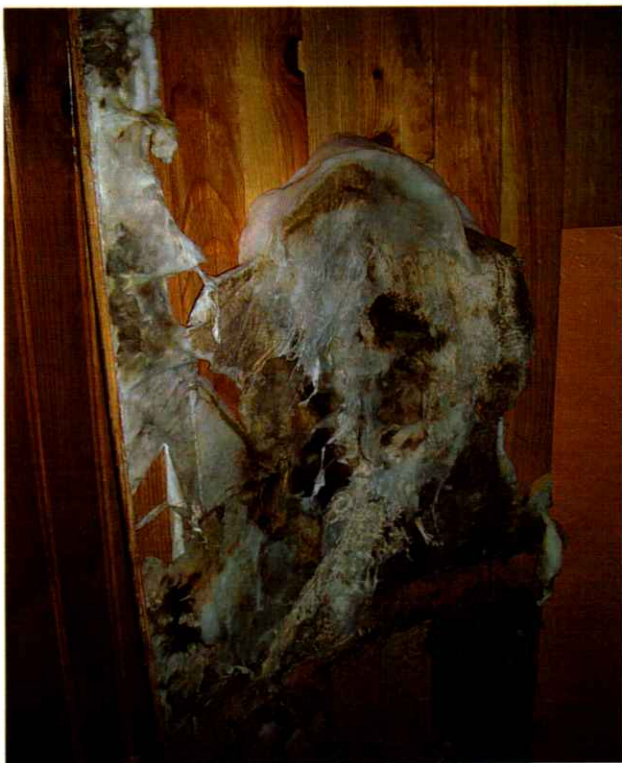
Mérule qui s'est développée entre le lambris et le mur humide
