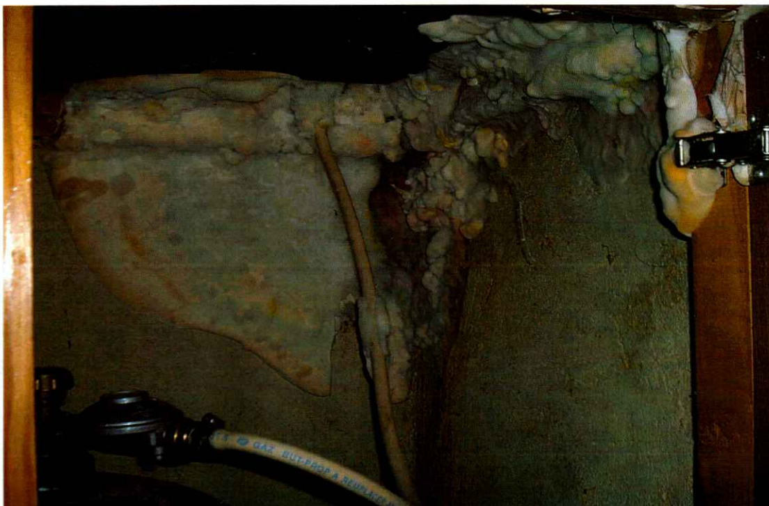
Mérule développée dans le placard d'un évier
