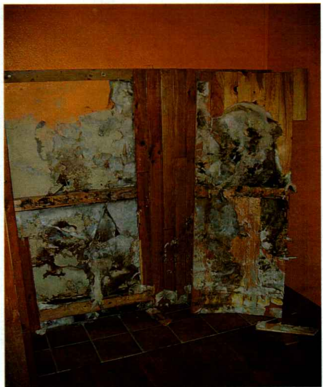
Mérule qui s'est développée entre le lambris et le mur humide
